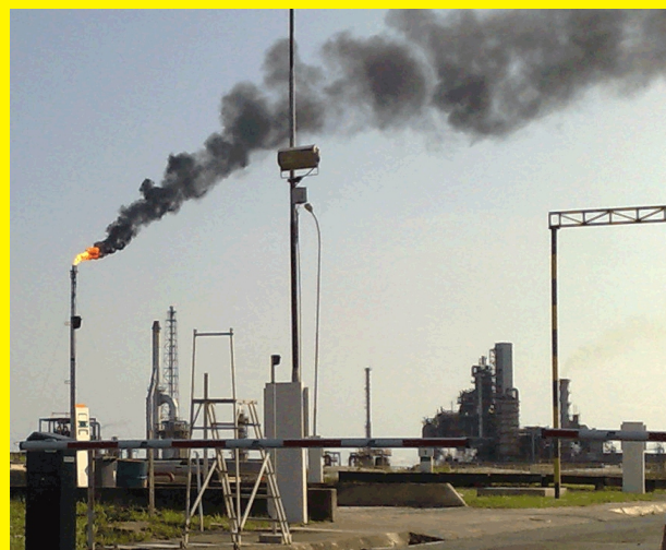
Degradação ambiental pela RLAM - Out. 2008
